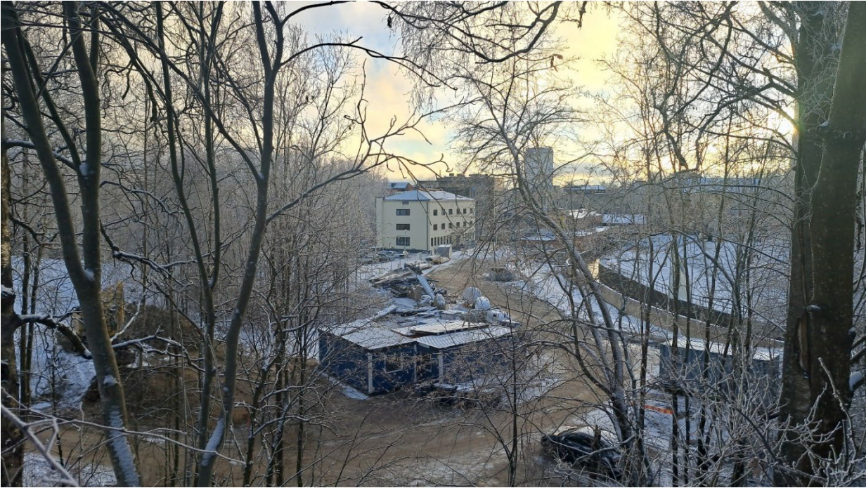
Kuva otettuna Rytin talon tontin kaakkoiskulmasta Kankaan alueelle päin joulukuussa vuonna 2024. Tourujoen rakennustyöt etenevät kuvan oikeassa laidassa. nk. Valkoinen talo näkyy kuvassa keskellä. Kuva: Jyväskylän kaupunki / Pekka Lassila.
