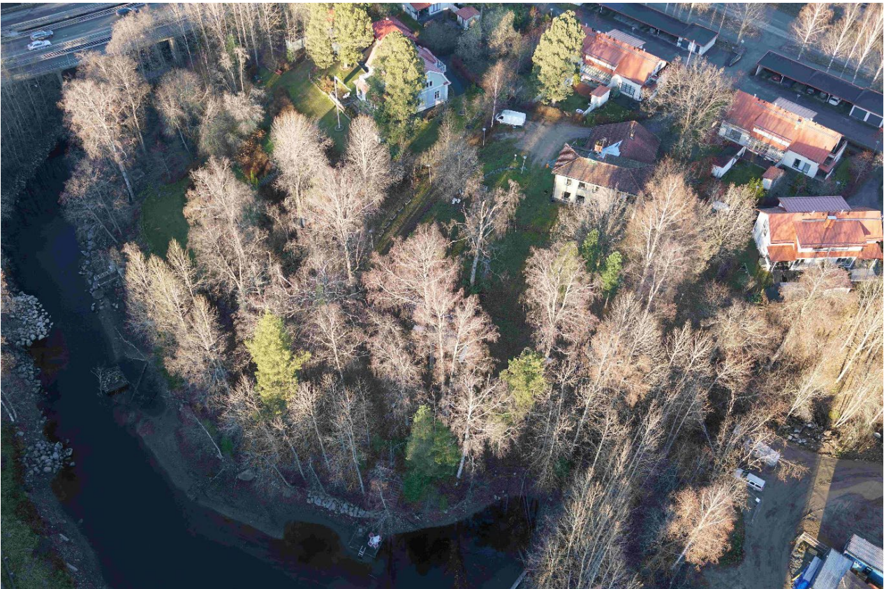
Kuva suunnittelualan eteläkulmasta marraskuussa vuonna 2024. Tourujoen rakennustyöt etenevät kuvan vasemmassa laidassa. Kuva: Jyväskylän kaupunki / kaupunkimittaus
